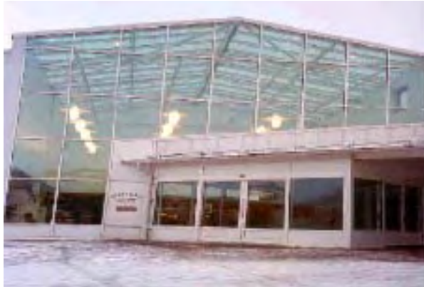
Fachada de la BP de Bålsta (8.000 habitantes). A pesar de que la biblioteca comparte edificio con el Instituto de Secundaria, todo tipo de usuarios visita el centro de lectura (420 usuarios de media diaria, 9'3 préstamos per cápita). Obsérvese el buzón de préstamo en el exterior.
