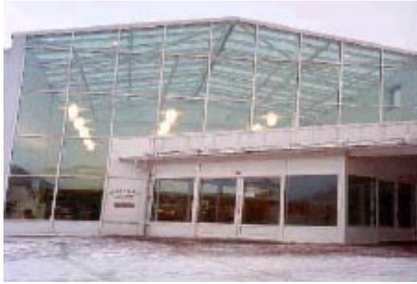
Fachada de la BP de Bålsta (8.000 habitantes). A pesar de que la biblioteca comparte edificio con el Instituto de Secundaria, todo tipo de usuarios visita el centro de lectura (420 usuarios de media diaria, 9'3 préstamos per cápita). Obsérvese el buzón de préstamo en el exterior.
