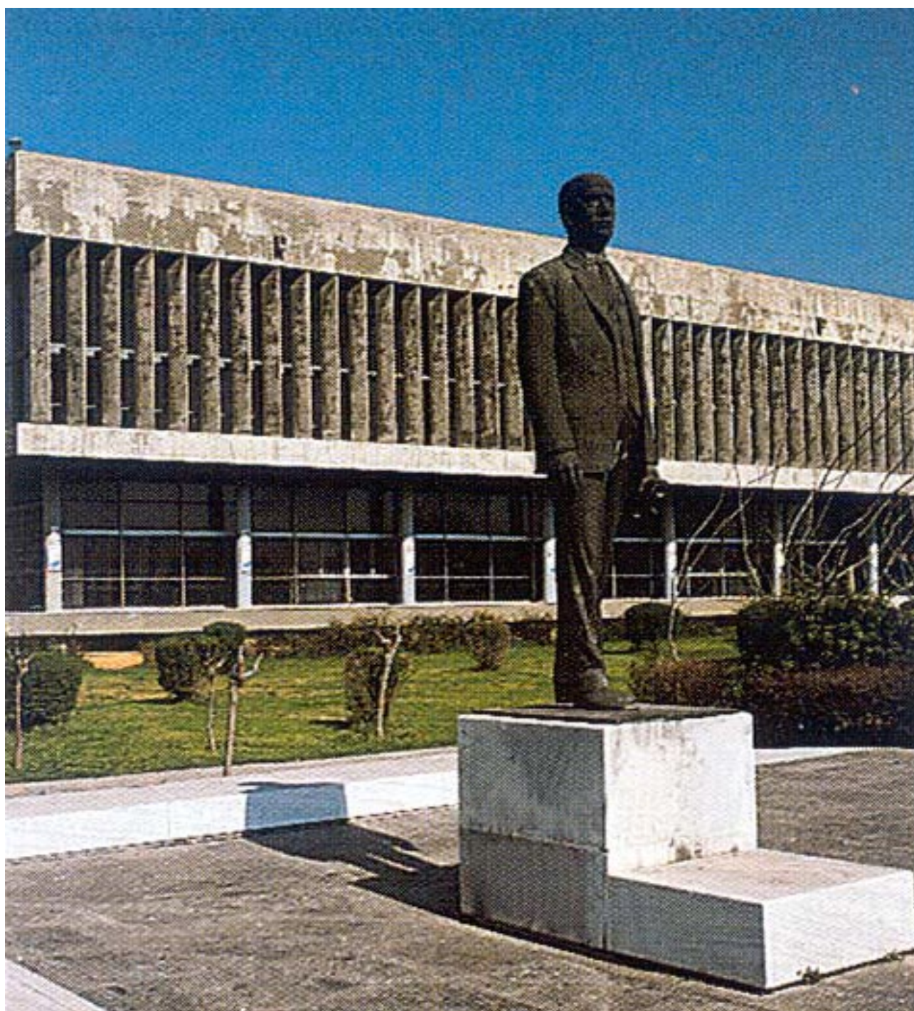
ANEXO 01: Vista exterior del edificio de la Biblioteca Central (precedida de la estatua de Alexandre Papanastasiou).
